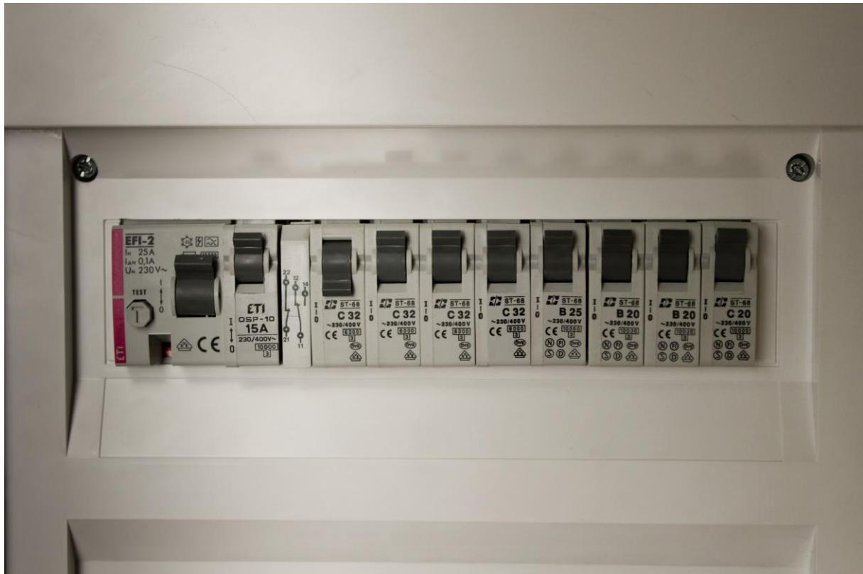
Na slici iznad je prikazana stara stanska tabla, u kojoj se nalazi klasična RCCB sklopka trenutnog tipa sa 8 automatskih prekidača.
